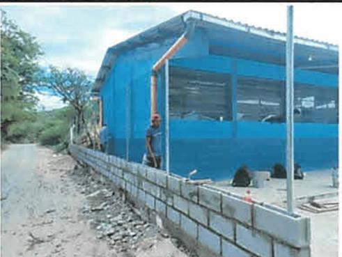
FOTO 3: CONSTRUCCIÓN DE MURO PERIMETRAL.
